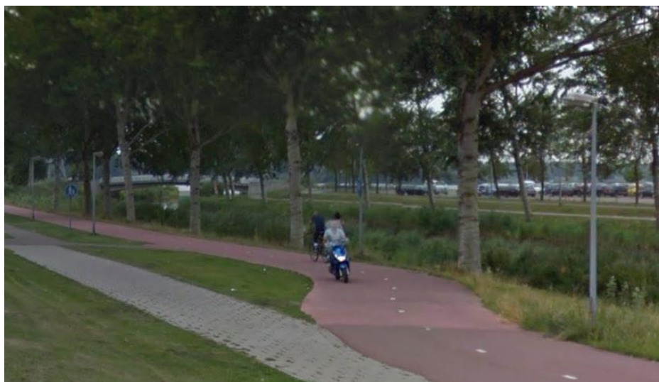
Afbeelding 4.2 Fietspad met betonverharding in omgeving met boomwortels
