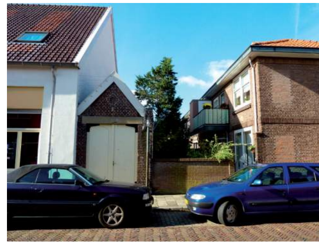
Entree aan de Oosterstraat met voormalige kleedkamer horend bij de gymzaal.
