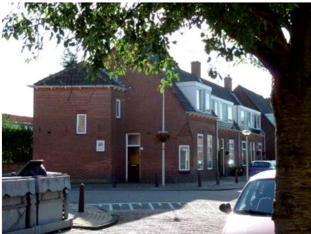
Architectonisch ensemble Plan I, kenmerkend aan de beëidiging van de blokken met torentjes, de bijzondere hoekbebouwing, de antraciete dakvlakken, de accenten in het metselwerk en de tuinmuren.
