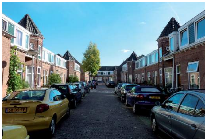
Huidige situatie van de De Ruijterstraat: het hofje met torentjes is nog duidelijk zichtbaar. Wel zijn dakkapellen samengevoegd, houten kozijnen vervangen door kunststof kozijnen en de verfijning in de vensters grotendeels verdwenen.
