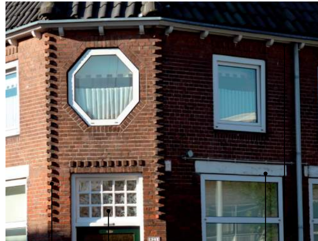
Detail in het metselwerk van de hoekbebouwing
