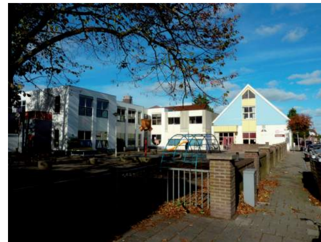
Zicht op het plein aan de Oosterstraat en de nieuwbouw uit 1982-1989.
