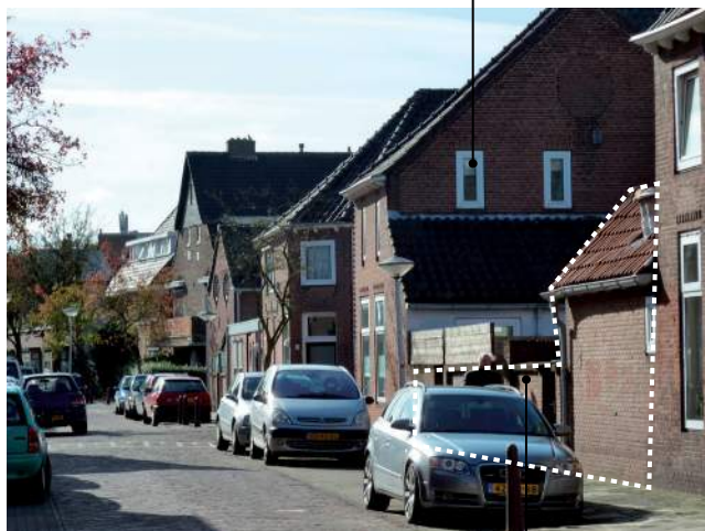
Tuinmuren en bergingen aan de straatzijde in metselwerk
