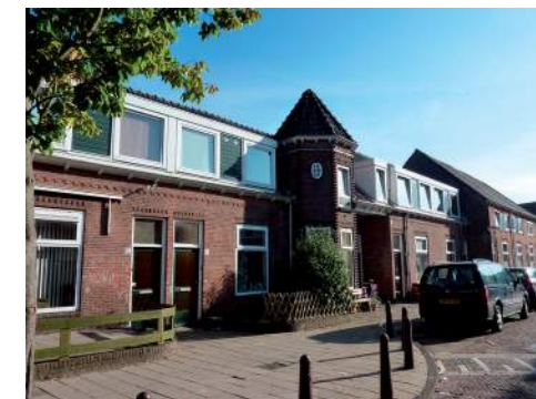
Twaalf woningen aan de De Ruijterstraat hebben een voortuintje waarvan sommigen zijn bestraat, maar nog wel zichtbaar vanwege het laag gemetselde muurtje.
