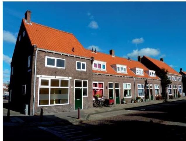
Architectonisch ensemble Plan II, kenmerkend aan de oranje dakvlakken, de afwisselende dwars- en langskappen, de gemetselde dakaccenten, wisselende goothoogtes en de gedetailleerde dakgoot.
