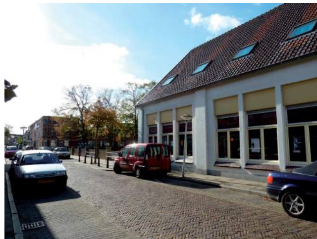
Resten van de vleugel aan de Oosterstraat. De verdieping is bij de vernieuwing tussen 1982 en 1989 afgebroken en vervangen door een dakkap.
