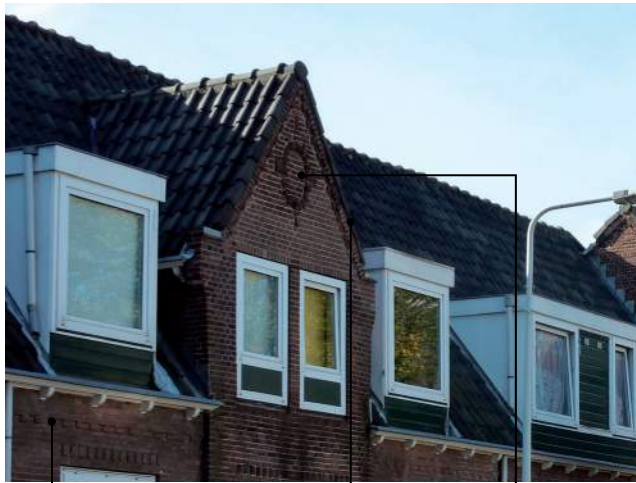
Metselwerkband onder dakgoot en aangezet latei boven de vensters
