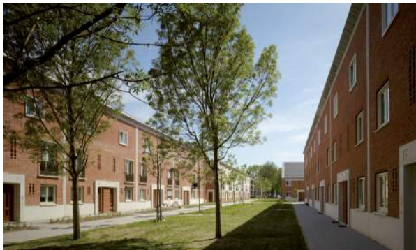
Geleiding gevel met minimale middelen: uitstekende daklijst, aanzet borstwering en entrees en verfijnd metselwerk detaillering. Complex in Pendrecht-Rotterdam, door Geuts & Schulze architecten.
