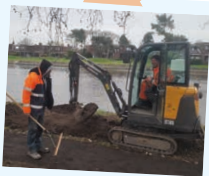
Aanleg pad langs Rijn-Schiekanaal, voorjaar 2019
